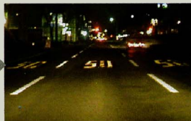
仙台市若林区での施工 (速度文字 真中が無鉛品、両端が従来品)
