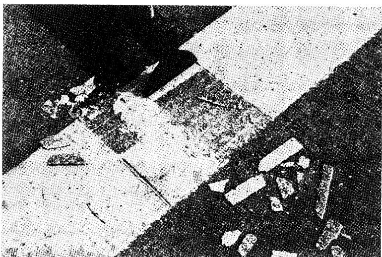
コンクリート舗装と、アスファルト舗装の対比では、アスファルト舗装への接着性が断然よい。コンクリート舗装路面に施工されたラインは、大小無数の気泡が発生していることと、表層のセメント層が非常にもりい現象がみられた。
