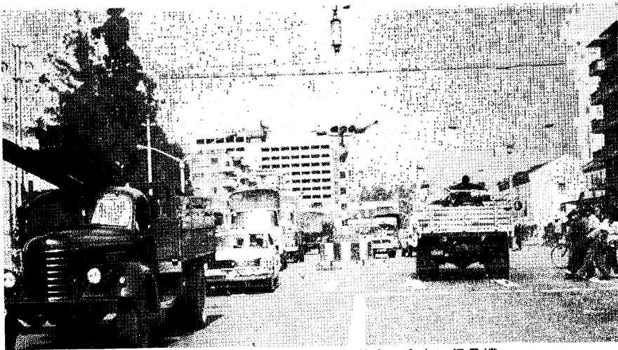
写真-5 溶融用施工現場 交差点, 中央に信号機
