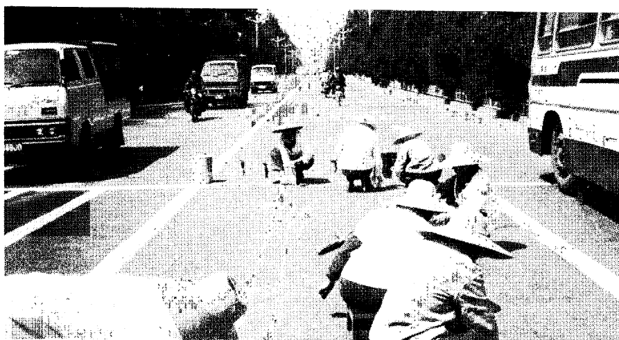
写真-2 昆明 ペイント施工現場, 水系による作図
