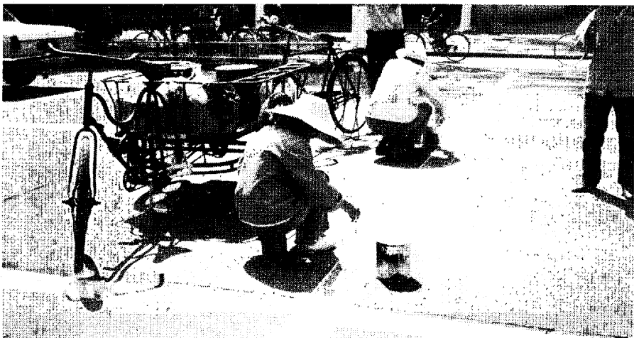
写真-3 ペイント施工現場, ハケ塗り
