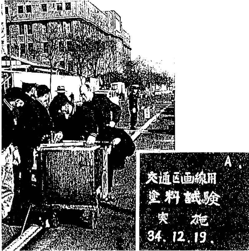
昭和34年12月 警視庁 試験施工
