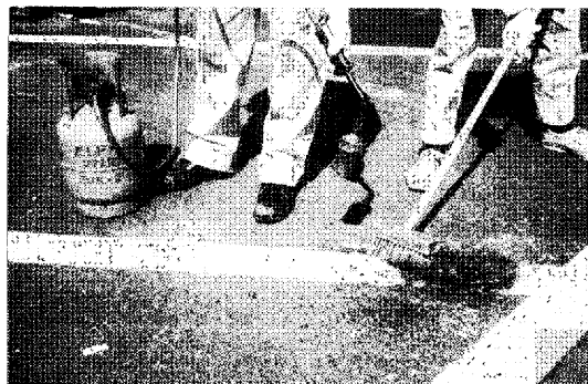
写真(2)-2 ワイヤーブラシによる均し作業
