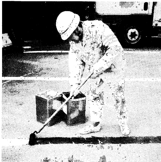
写真 (1) - 1 黒色ペイント（常温）による塗装作業
