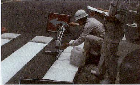
すべり抵抗測定状況
