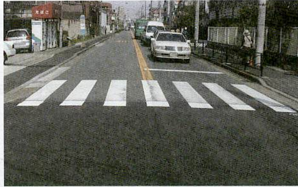
施工前全景写真
