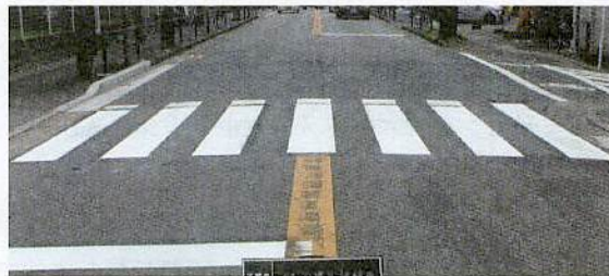
施工直後状況
