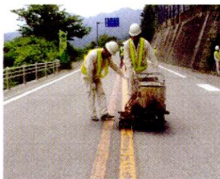
無鉛塗料施工中
