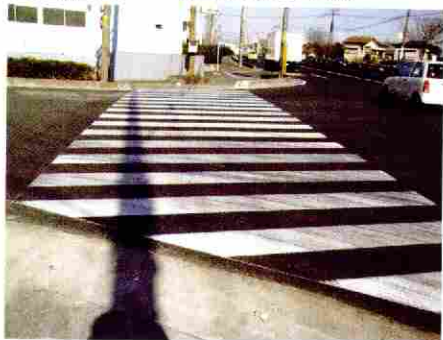
施工直後 (接写)
