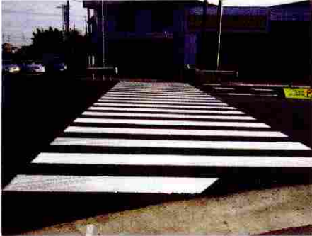
施工直後（接写）
