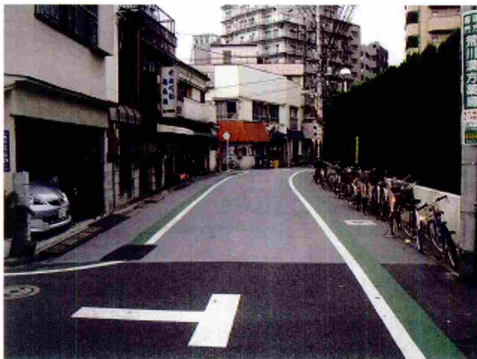
図5. 遮熱性舗装の施工例
