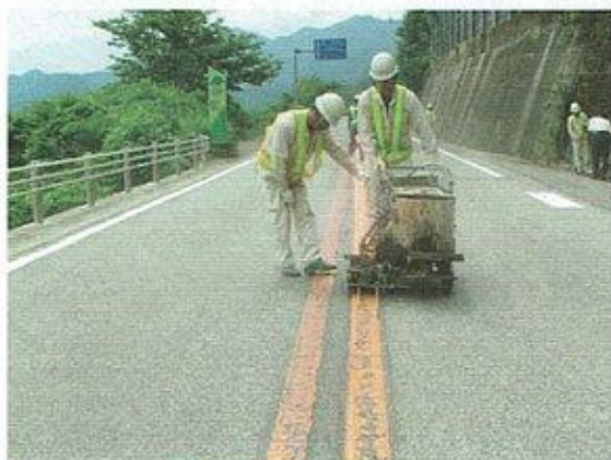
鉛・クロムフリー黄色塗料施工中
